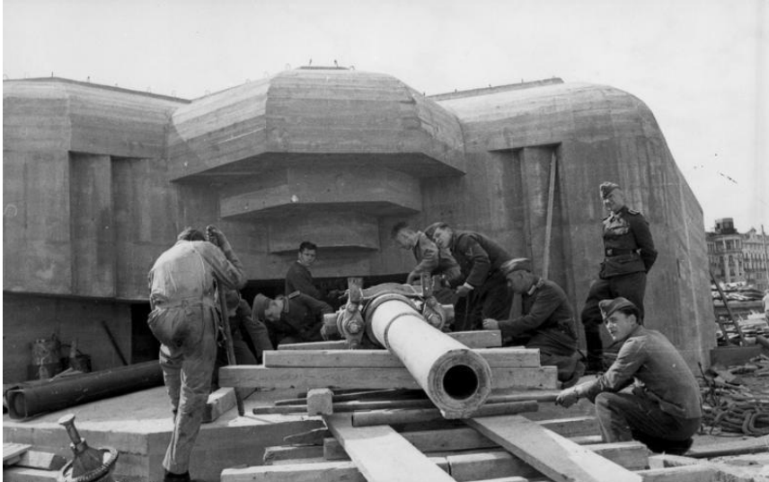
Montaje de un cañón en un búnker en el Norte de Francia. Muro occidental. Junio 1943
